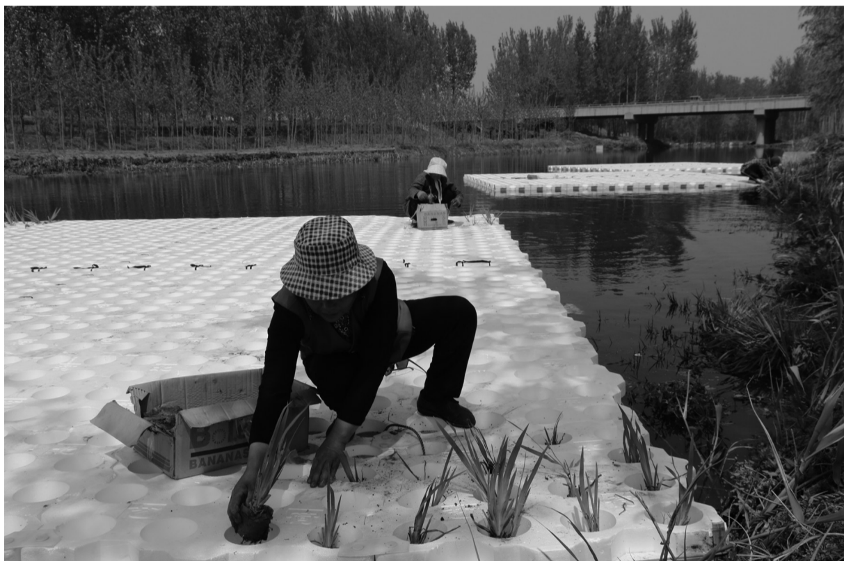
近日，蟠龙河湿地公园河面上种植了一排排水上绿植，形状似一块块漂浮在水面上的“浮岛”，远远望去，亭亭自碧。这些水上绿植不仅对治理水质起到了重要作用，也成为公园里一道亮丽的风景线。据了解，人工浮岛是当前净化水质的一项新技术，专业人员在岛上栽种紫花鸢尾和千屈菜2种挺水花卉，既可净化水质，又可成为景观。
