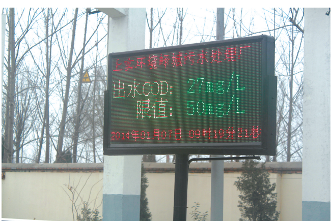
污水处理厂电子显示屏,时时在线显示出水口浓度
