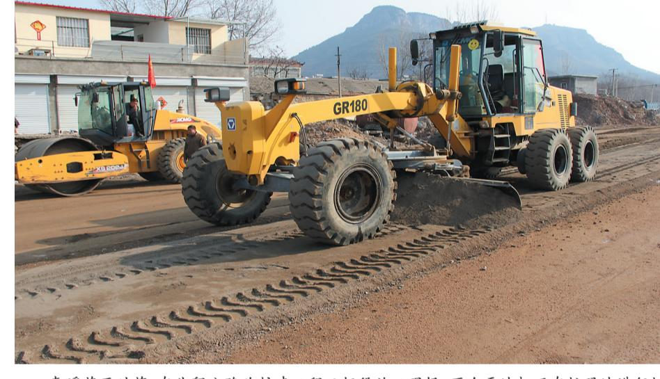
春暖花开时节,在北留公路改扩建工程二标段施工现场,两台平地机正在忙碌地进行摊铺、平整路面工作。工程施工人员抢抓当前晴好天气,加班加点赶进度。截至目前,现场清理已全部完成,路基填筑已完成86.3%,冲击碾压已完成81.2%。
