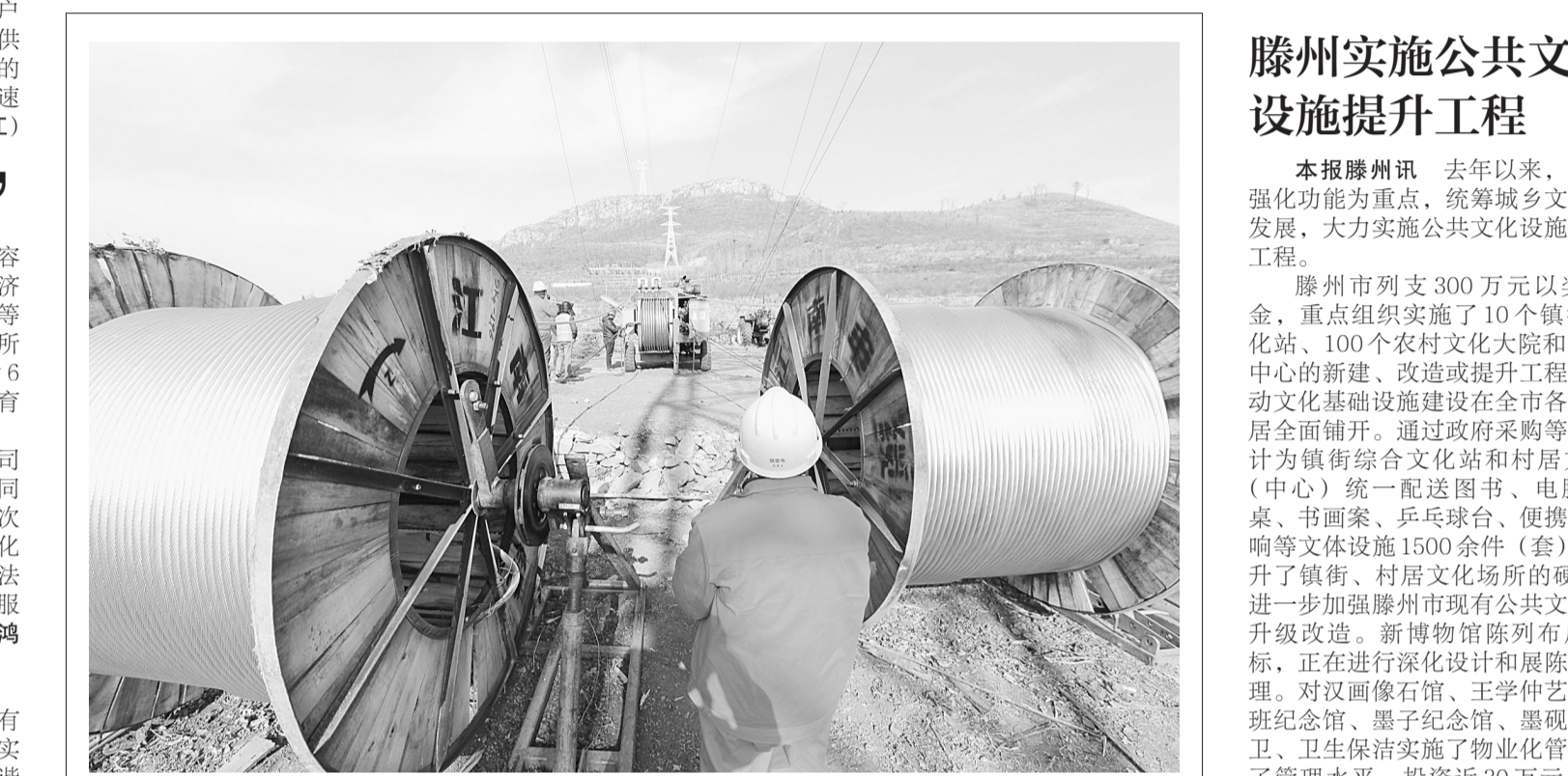
电力助推经济发展 2014年12月25日,在沙沟镇邵楼220千伏输电工程施工现场,承建该工程的枣庄力源送变电工程有限公司正在进行铁塔放线工作。该工程是枣庄供电公司支持新城南部地区经济发展而建设的又一电力工程。(王飞龙 王鹏 摄)
