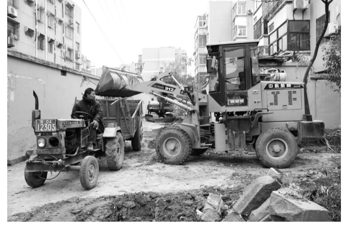
近日,结合全区开展的第一次集中走访活动,文化路街道龙凤社区经过认真汇总梳理,对辖区环境卫生进行了集中清理整顿,同时,对清理整顿后的路面进行修补硬化,切实惠民生,解民忧。
