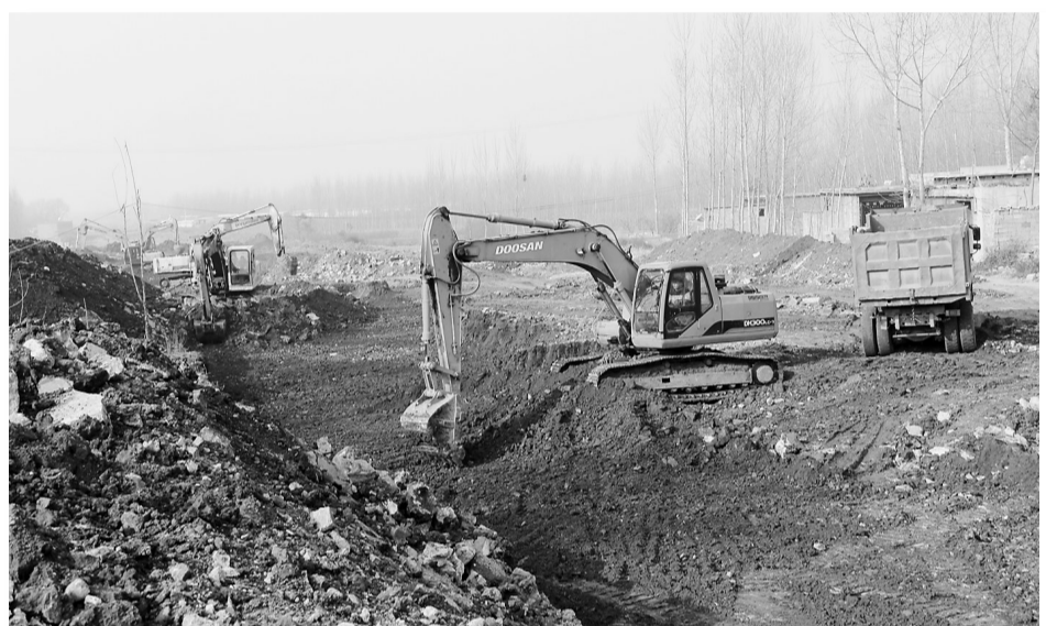
初冬时节,在省道S343北留公路改扩建工程(山亭段)施工现场一片繁忙景象。挖掘机挥动着铁臂上下舞动,运输车开足马来回穿梭,压路机轰鸣着碾压着路面……据了解,截至目前,全线完成清表27.645万平方米,占总工程量的72.9%;完成冲击碾压12.393万平方米,占总工程量的26.4%;完成路基土石方6.311万立方米,占总工程量的13%,为建设高质量、高标准的道路工程做好了铺垫。(郑秀萍 摄)
