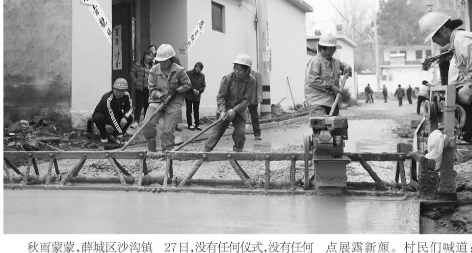
秋雨蒙蒙,薛城区沙沟镇郭洼村的主干道上,机器的轰鸣声此起彼伏,一辆辆大型商品混凝土罐车在自南往北的道路上浇筑着混凝土,郭洼村的第一书记刘东正戴着安全帽蹲在刚刚浇筑的路边,用一把小锤子帮修路工人压着钢丝线。
