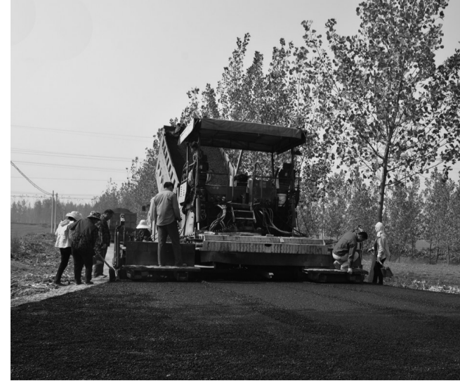
日前，西王庄乡前古屯村至店子村路段20厘米水稳沥青路面铺设正在紧张进行。
