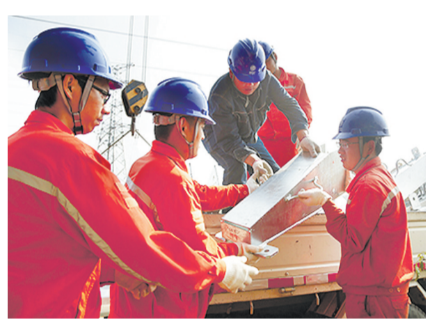
10月13日,枣庄供电公司滕州客户服务分中心30余名员工在东郭镇温庄村南组立钢管塔,加紧进行110千伏温庄变电站出线架架线施工。110千伏温庄变电站10千伏配出线路工程是枣庄电网秋检重点项目之一,共需组立钢管塔45基,立杆500基。滕州客户服务分中心主动克服困难,创造宽松的施工环境,同时,严格执行现场标准化作业指导书,加强“老虎口”和危险点的管控,安全、优质、高效地施工,努力为东郭镇经济发展和居民生活用电提供坚实可靠的保障。(通讯员 班开超 王威 摄)
