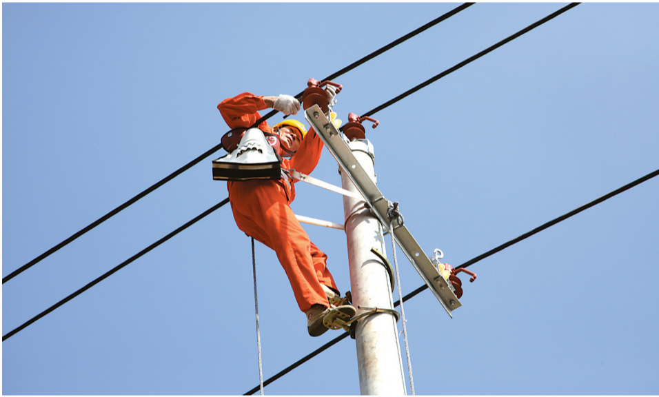
针对农村电网建设和改造任务重、工期紧的实际，国庆长假期间，枣庄供电公司山亭客服中心10多个施工队的300余施工人员主动放弃长假休息时间，全力推进施工农网建设改造进度。图为10月6日，20多名施工人员正在对新建的10千伏徐庄线路进行放线施工。(于绍迎)
