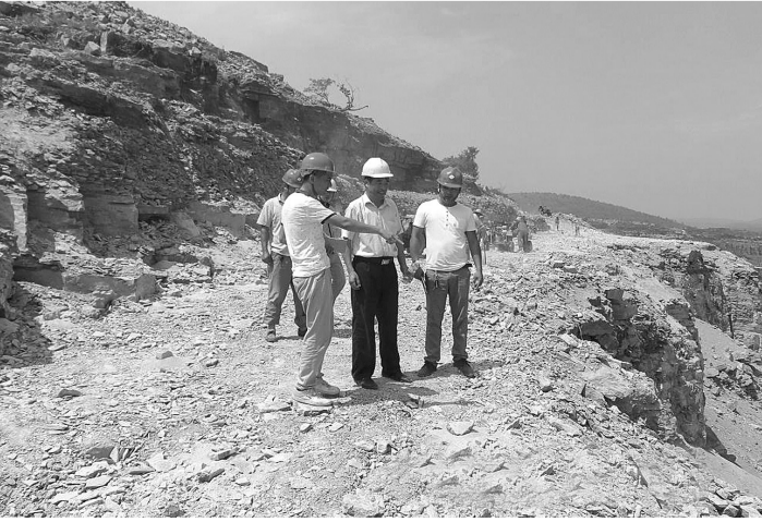
枣庄市冠世榴园景区市中辖区破山体矿山地质环境治理工程现场
