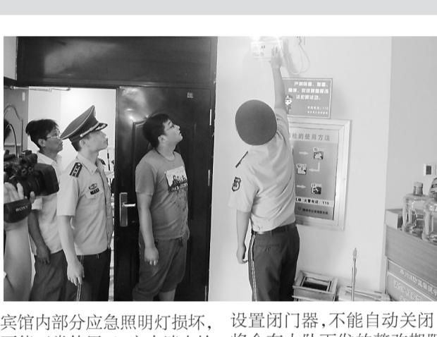
宾馆内部部分应急照明灯损坏,不能正常使用;2、室内消火栓无水,剩余的隐患(防火门未
