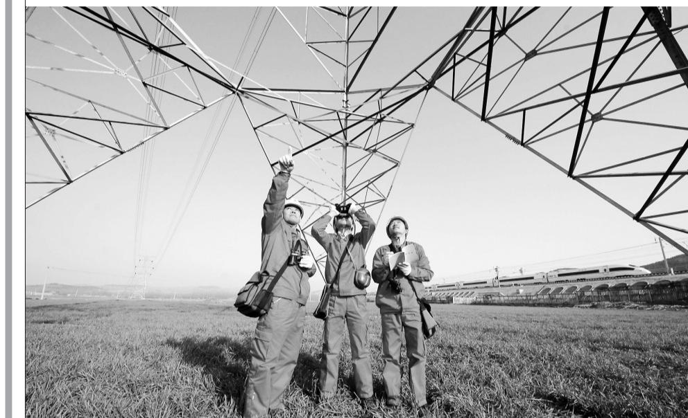
这张2012年2月1日的资料照片显示,国网山东枣庄供电公司市中客户服务中心专业技术巡查队巡视京沪高铁供电线路。春运期间,国网山东枣庄供电公司市中客户服务中心安排人员对京沪高铁枣庄段境内60.4公里的4条220千伏高铁牵引站供电线路及206基铁塔进行全天候巡视检查,确保京沪高铁供电线路正常运行。据中国铁路总公司消息,截至2014年6月30日,京沪高速铁路开通运营已满三周年。三年来,京沪高铁全线发送旅客已突破2.2亿人次,日均客运量不断攀升。随着连接京沪高铁多条高铁线路开通,京沪高铁作为高铁路网干线通道地位日显突出,全线开行列车由最初90对增加到128对,2014年春运创造了单日开行303列最高历史记录。(吉喆 姜倩 摄)
