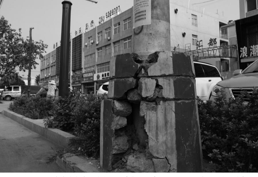
6月10日,市民李先生打来热线电话称建华路和建国路交叉口西南侧一个电线杆底座破损严重。很长时间了一直无人修理,非常危险。随后,记者来反映问题的这处电线杆底座,只见路口的水泥电线杆水泥底座有数条裂缝,最宽的裂缝里边的石砖完全裸露,丢失了数块石砖。一位在附近开店铺的市民李女士说,“这个底座如果再不修理,很可能导致电线杆倾斜,非常危险,希望有关部门及时对破损的电线杆底座进行修复。”
