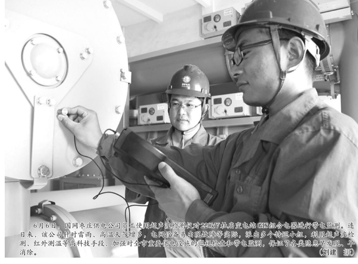
6月6日,国网枣庄供电公司员工使用超声波检测仪对220kV杜庙变电站GIS组合电器进行带电监测。连日来,该公司针对雷雨、高温天气增多,电网设备易出现故障等实际,派出多个特巡小组,利用超声波检测、红外测温等高科技手段,加强对全市重要供电设施的巡视检查和带电监测,保证了各类隐患早发现、早消除。(刘建 摄)
