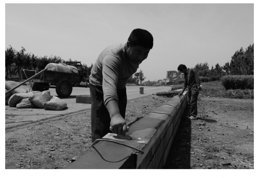
连日来，孟庄镇在旅游大道孟庄段崖头、苗庄村实施沿村道路绿化工程，再次吹响了创森冲刺的号角。目前，全镇新增绿化面积6760亩。
