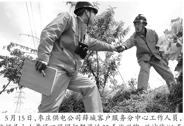
5月15日,枣庄供电公司薛城客户服务分中心工作人员,对途经圣土山黄风口段同杆架设的35千伏兴陶、兴沙线#1至#22杆塔进行特巡,及时发现消除缺陷,确保沙沟、周营两镇在夏季雷雨季节安全供电。 (吴超 摄)
