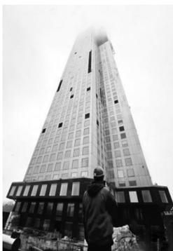
据施工方介绍,大楼采用可持续建筑模块化材料,95%的工程量在远大工厂内完成。大楼外墙采用多种特有技术,据称比常规建筑节能80%。目前,大楼已完成主体封顶,转入墙体及内部装修阶段。(中新)
