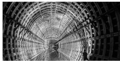
乌克兰基辅废弃的隧道
