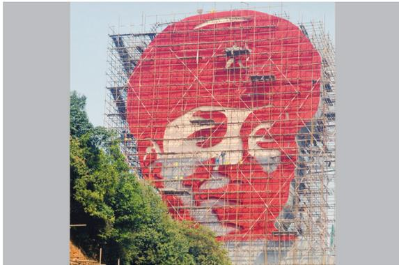
10月11日,一尊巨型雷锋头像艺术雕像在长沙雷锋大道望城区路口初现雏形。雕像为钢筋混凝土材质,高30米,厚6米,目前已完成主体工程,预计本月底完工。此雕像将作为进入雷锋故鄉的标志,寓意着雷锋精神长存,雷锋故乡望城经济腾飞。
